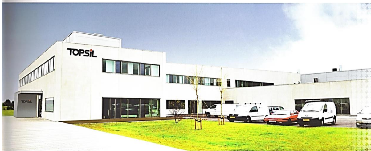
Topsil nye fabrik på siliciumvej 4 i Frederikssund
