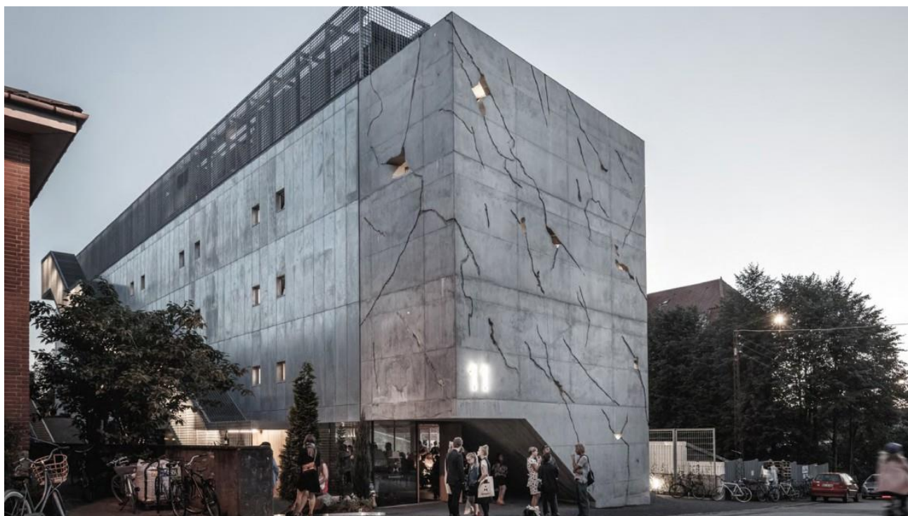
Gavl af betonelementer lavet med Odicos robotteknologi
